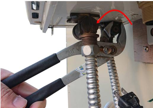
給湯水抜き後に給水栓の奥にある給湯栓をプライヤー等で緩めて下さい。
