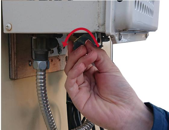
手で緩めれるようになったら、給水水抜栓を外して下さい。
