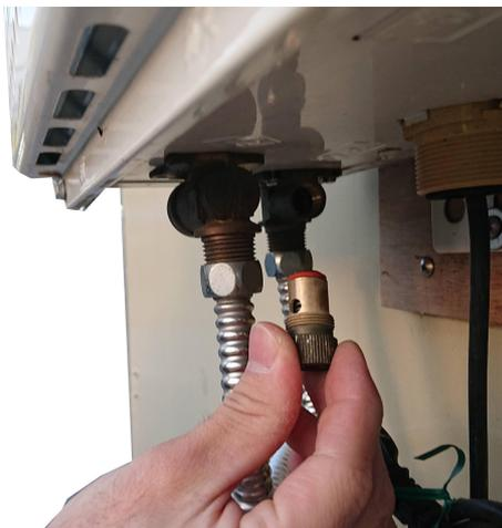
給湯栓を外して水が出なくなるまで水を抜いて下さい。
